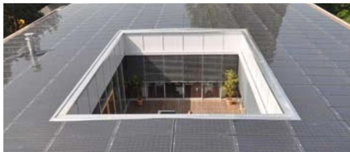
600 m<sup>2</sup> Photovoltaik auf Dächern und Fassaden für einen Peak von etwa 80 kW.
